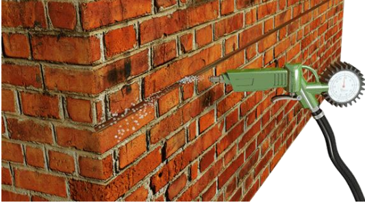
Obrázek 2 – Frézování drážky
