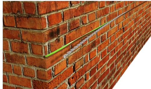
Obrázek 5 – Vložení prutu helikální výztuže do malty v drážce
